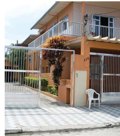
Reforma e portão eletrônico na Colônia antiga
